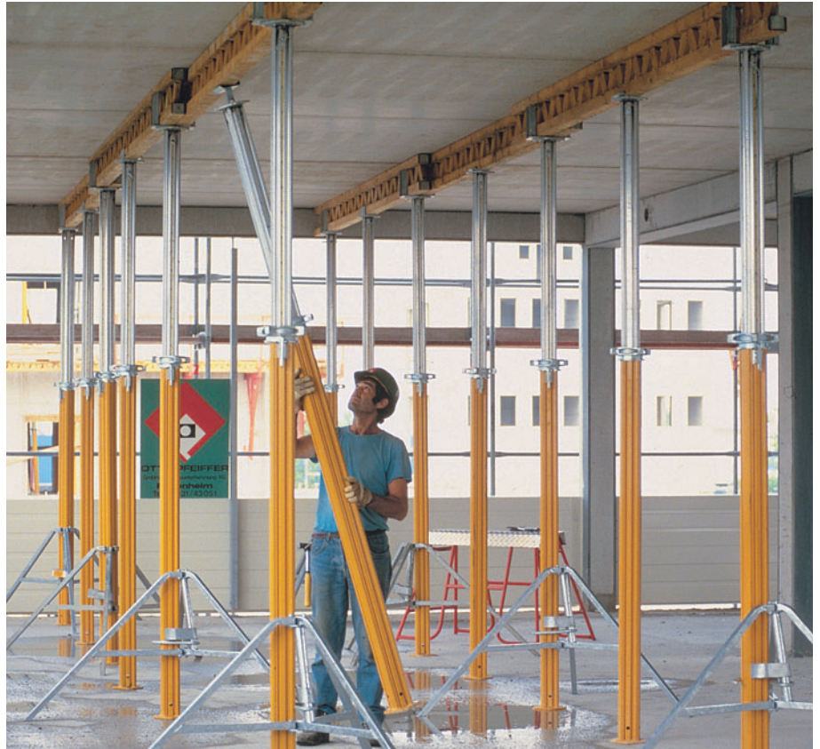
Leichtes und bequemes Bedienen der MP 350 von nur einem Mann. Das geringe Gewicht von nur 18,8 kg macht dies möglich.
