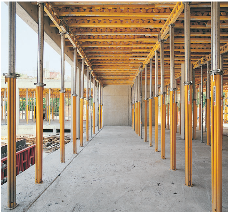
MULTIPROP 350 mit Deckenschalung MULTIFLEX.
