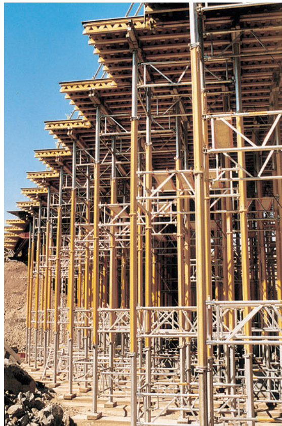
MULTIPROP Türme 8,80 m hoch, als Unterstützung von Deckentischen.
