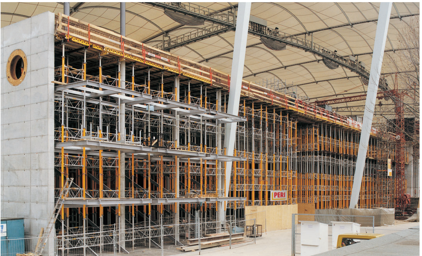
Sicheres Abtragen hoher Lasten: 14,00 m hohes MULTIPROP Traggerüst auf einer Fläche von 3.500 m 2 .
