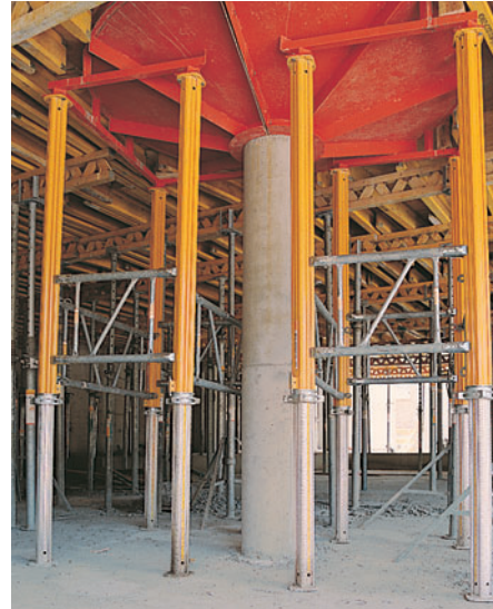
MULTIPROP Türme, 20 m hoch zum Einrüsten einer auskragenden Deckenplatte.
