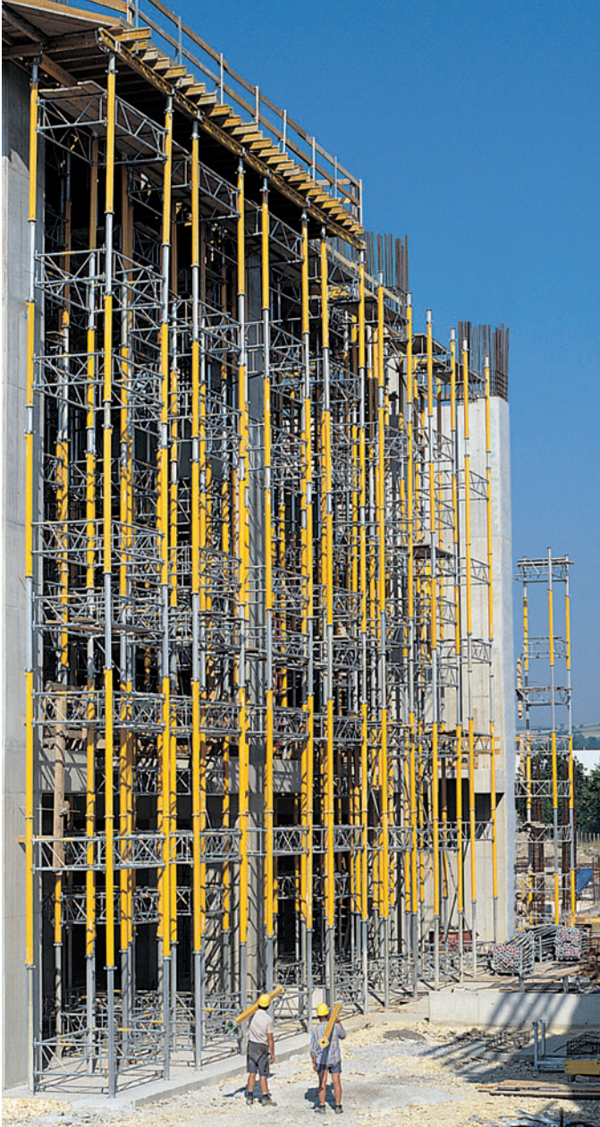
MULTIPROP Türme, 20 m hoch zum Einrüsten einer auskragenden Deckenplatte.
